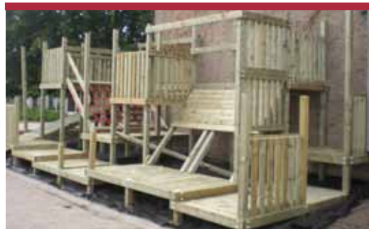
speeltoren in volle opbouw
